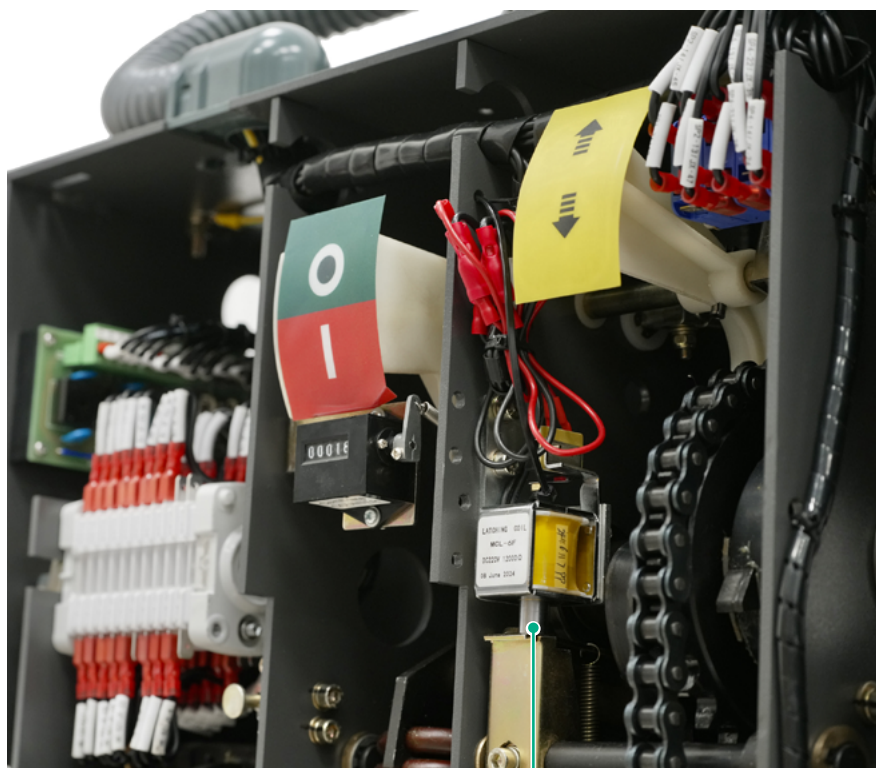
Пружинно-моторный привод типа «R»
